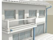
Controllate periodicamente il sistema di scolo delle acque piovane da tetto, terrazzo e balcone (grondaia, pluviali, ecc.), tenetelo libero da intasamenti e ripulitelo.
