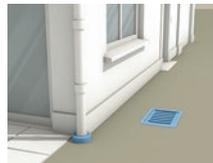
Controllate e pulite regolarmente anche gli scarichi all'esterno dell'edificio e il sistema di drenaggio (pozzetti e tubazioni drenanti, ecc.).
