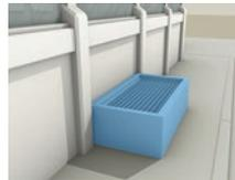
Le bord supérieur des conduites d'aération ou soupiroux ne doit pas dépasser le niveau d'eau maximal indiqué sur la carte des dangers. Au lieu d'une fosse septique, raccordez une évacuation à la canalisation.
