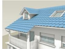
Contrôlez chaque année les tuiles, fixez les tuiles lâches, remplacez celles qui sont endommagées. Faites vérifier tous les 5 à 10 ans par des professionnels, notamment la pose de crochets tempête. Dans les zones à risques, sécurisez les tuiles avec des crochets tempête.
