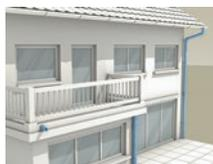
Veillez à ce que les évacuations du toit, de la terrasse et du balcon (gouttière, tube de descente, etc.) ne soient pas bouchées, nettoyez-les et vérifiez-les régulièrement.
