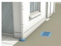
Vérifiez régulièrement et nettoyez tous les conduits d'écoulement également en dehors du bâtiment, les conduites de drainage (conduites et bouches d'évacuation des eaux).
