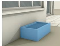
Le bord supérieur des conduites d'aération ou soupiroux ne doit pas dépasser la hauteur d'écoulement maximale indiquée sur la carte des dangers.
