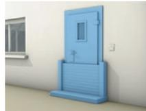
Disposez les portes du côté opposé au couloir d'écoulement ou étanchéifiez et consolidez-les en tenant compte du niveau d'eau maximal. Fermez les portes de l'extérieur et protégez-les par un système anti-inondation certifié.
