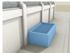
Il bordo superiore dei pozzi di ventilazione e di luce deve essere più alto del livello massimo dell'acqua indicato dalla carta dei pericoli. Invece di usare un pozzo di drenaggio collegate le grondaie alla canalizzazione.
