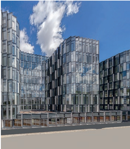
Immeuble de bureaux Résonance à Paris-Bagneux (Image: Schroders)
