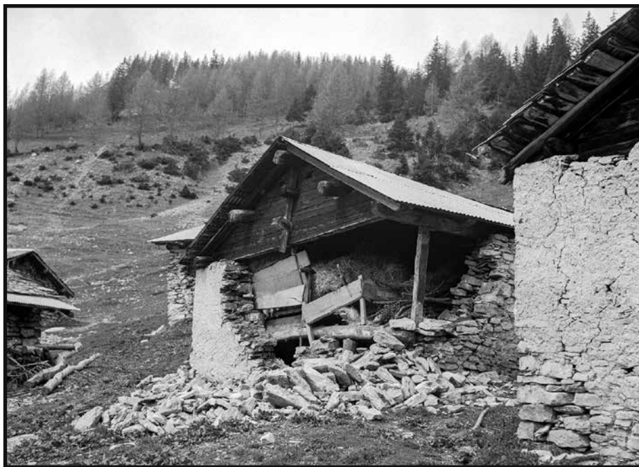
1946 wurde die Schweiz letztmals von einem schweren Erdbeben heimgesucht. Die Archivbilder zeigen Arbeiter beim Aufräumen und zerstörte Gebäude im Wallis.
